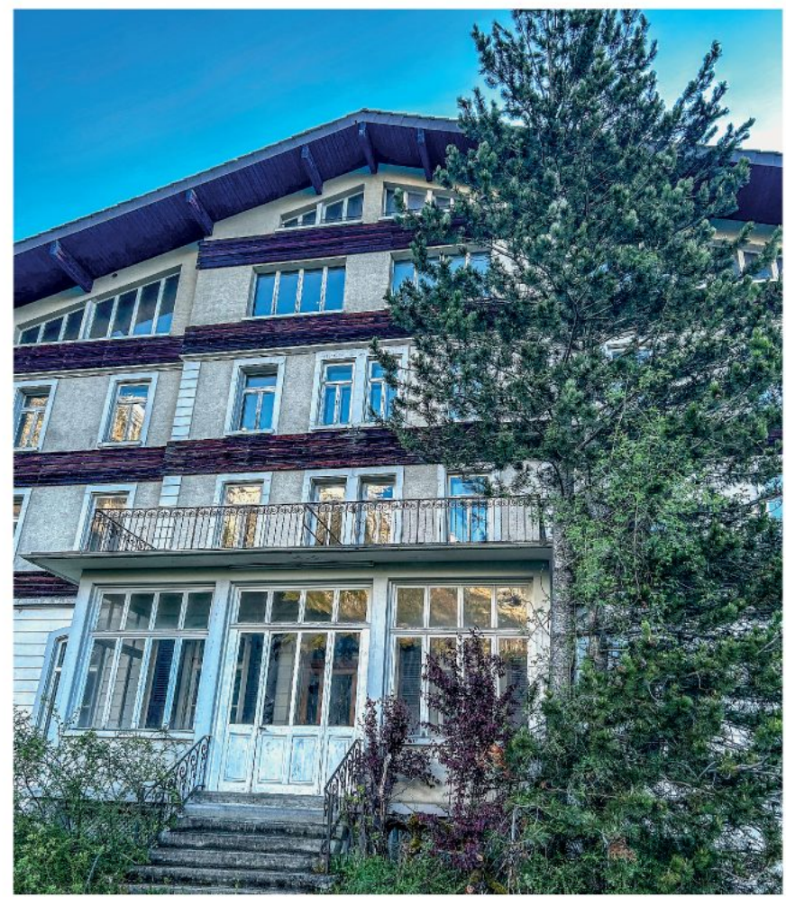
Das Gebäude in Kandersteg soll laut Gesuch des Kantons saniert werden. BILD: HANS RUDOLF SCHNEIDER
